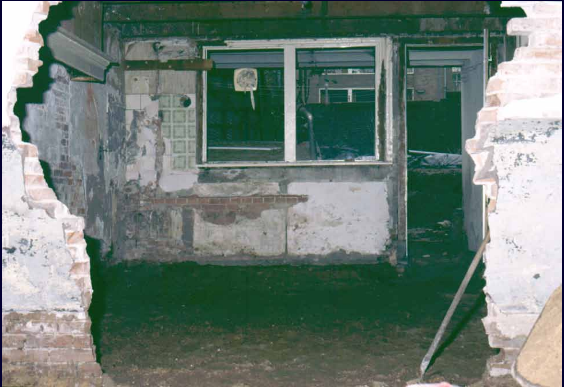
1987 • souterrain achter, vloer eruit
