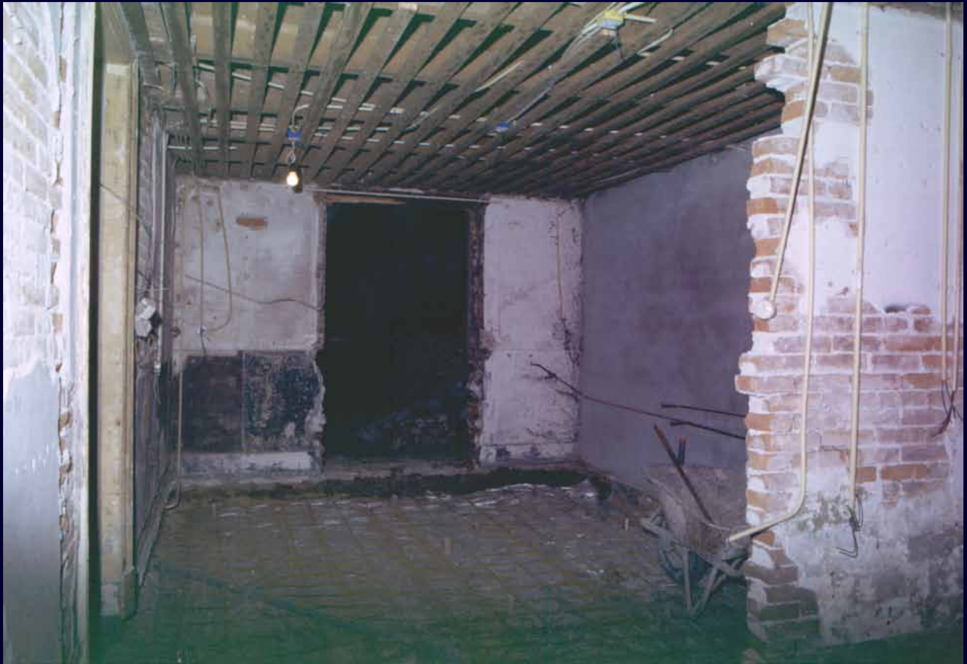
1988 • klaar om beton te storten in de keuken
