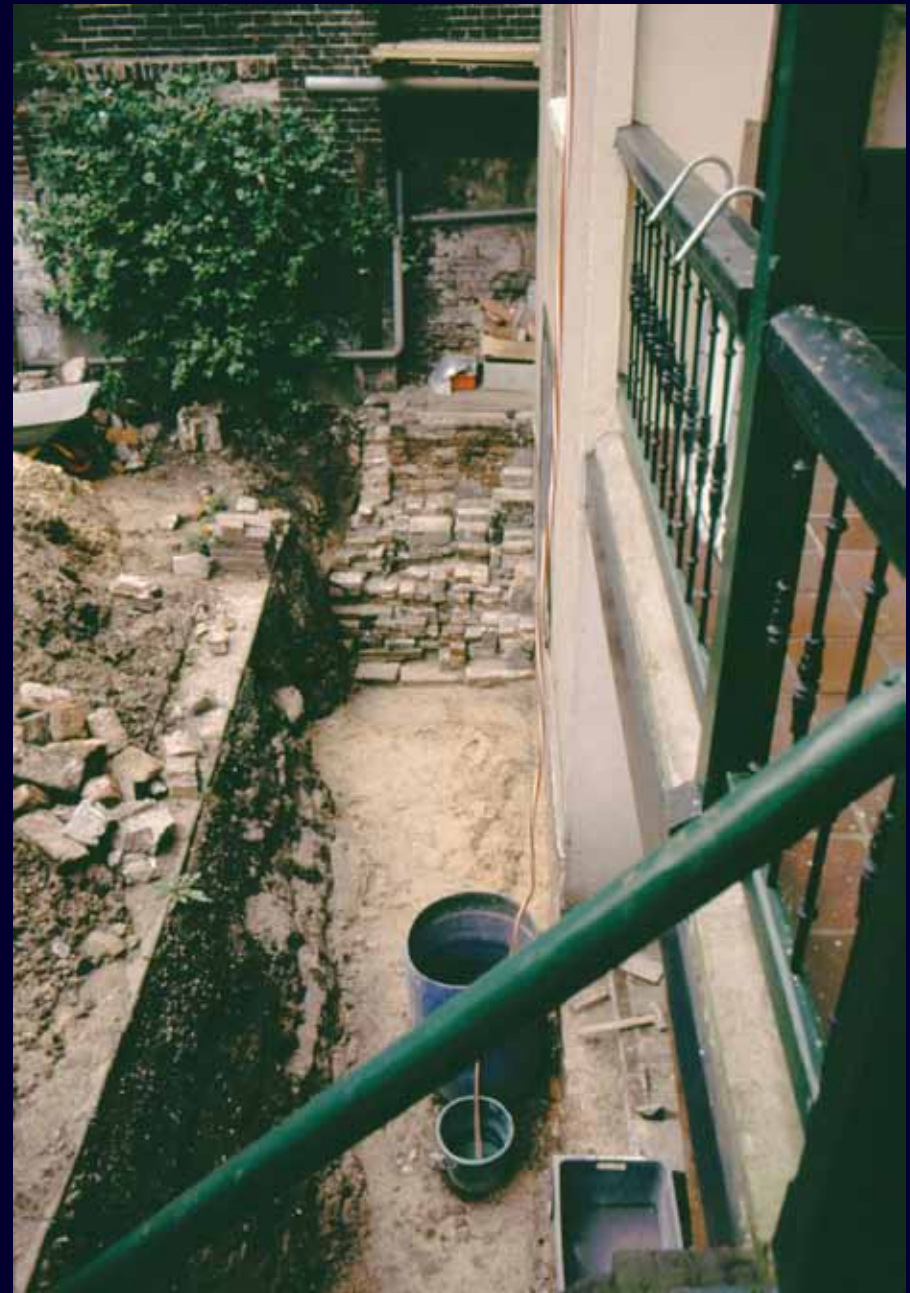
1985 • afgraven achtertuin om de gevel vrij te maken van grond
