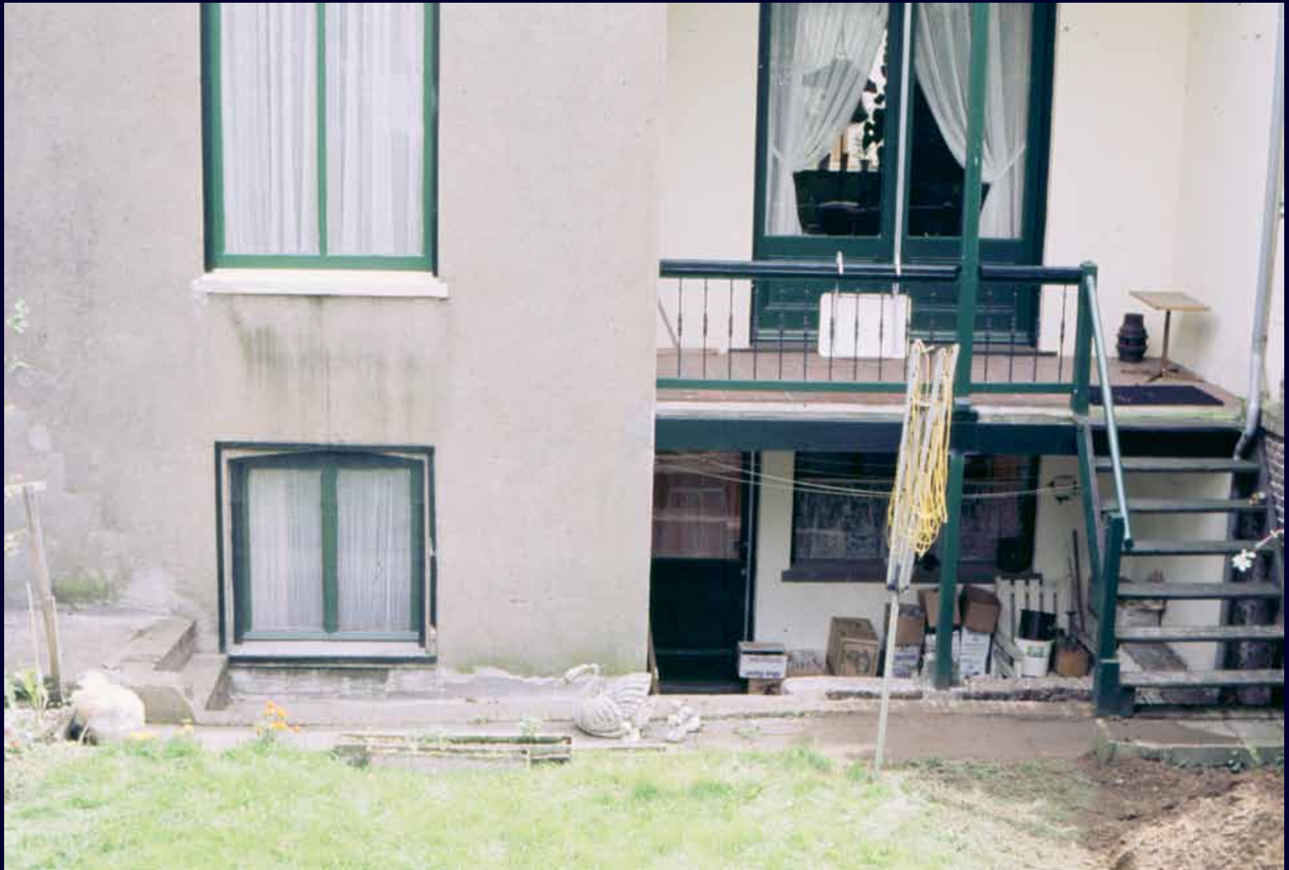
1984 • De achterzijde voor de verbouwing.
