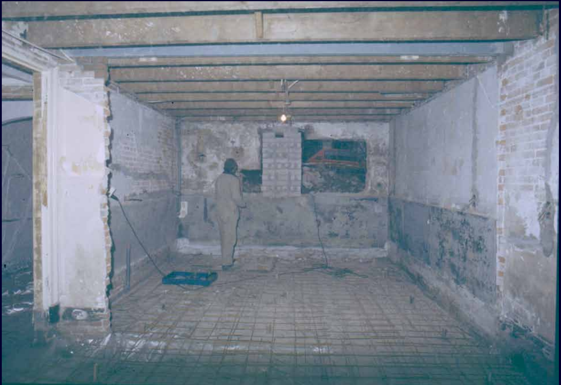
1988 • voorbereiding plaatsen kozijnen voorzijde
