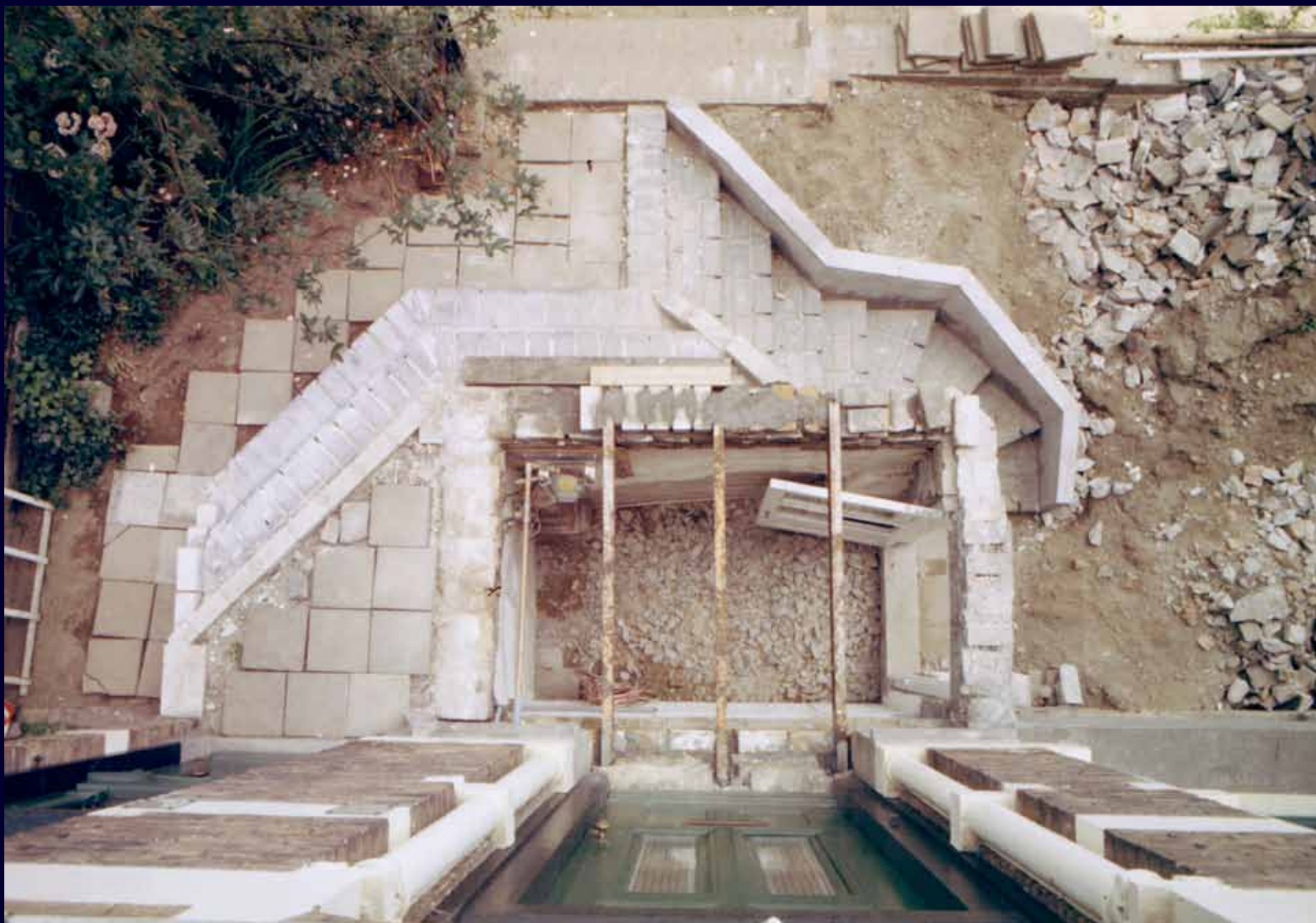
1988 • de laatste fase, het uitgraven van de stoep aan de voorzijde
