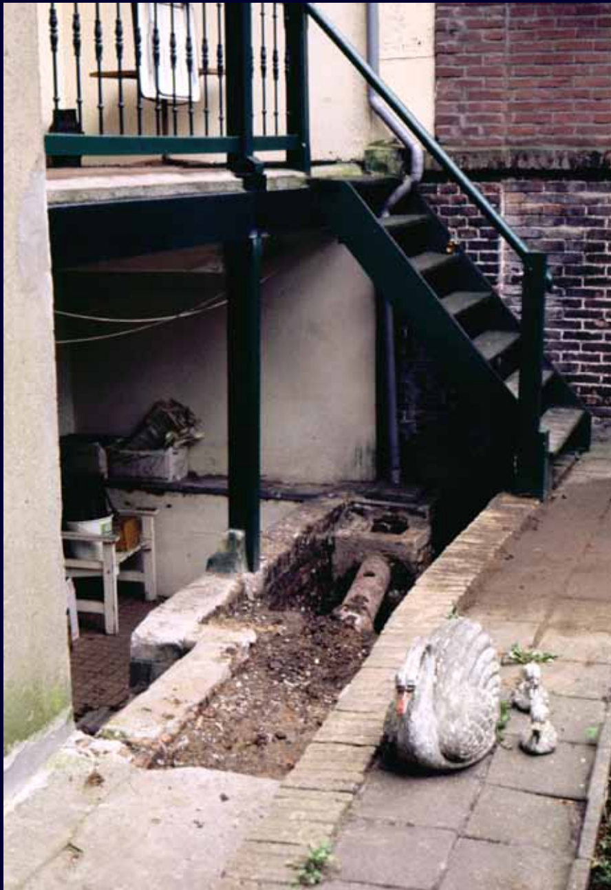
1985 • afgraven achtertuin om de gevel vrij te maken van grond
