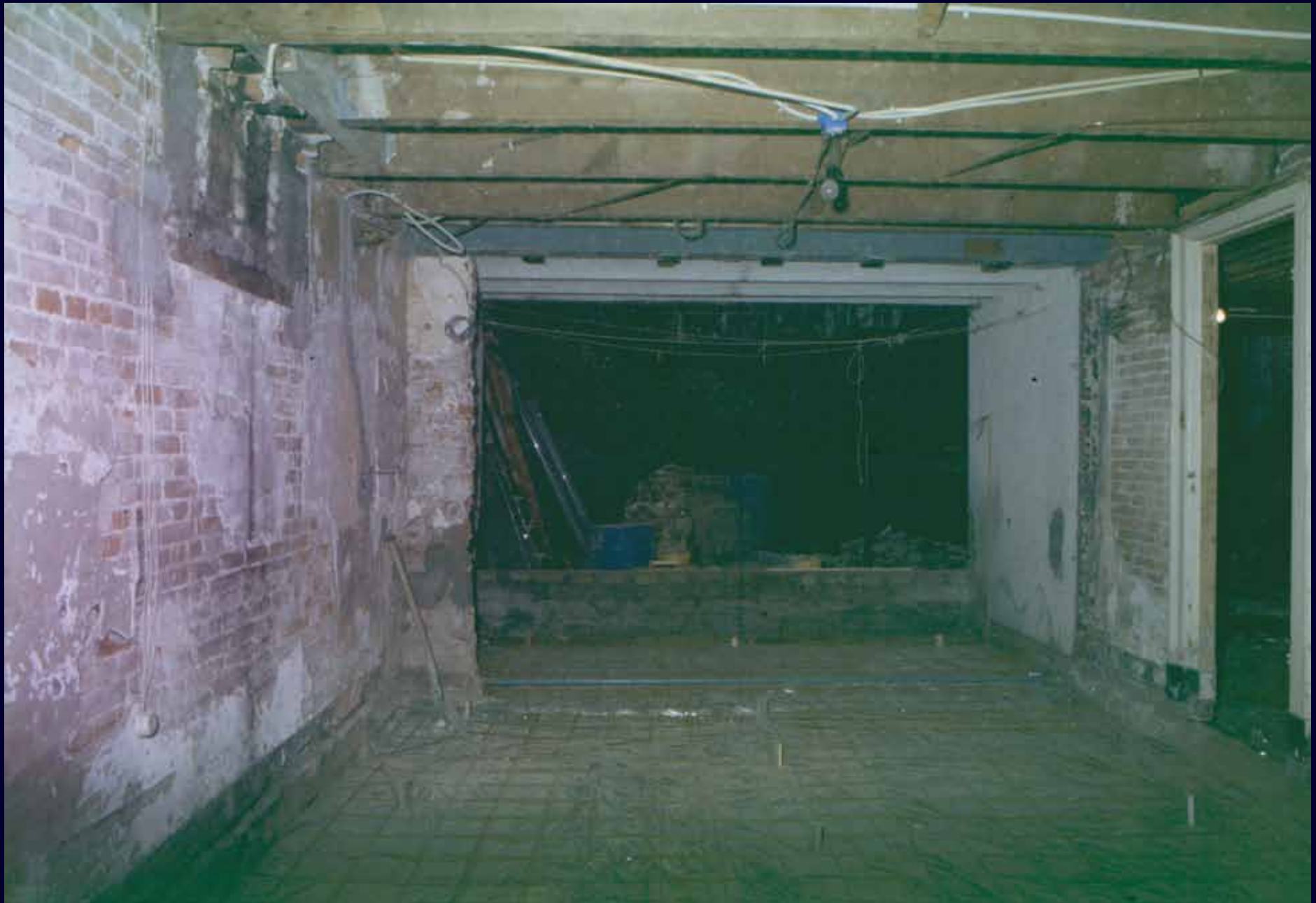
1988 • klaar om beton te storten
